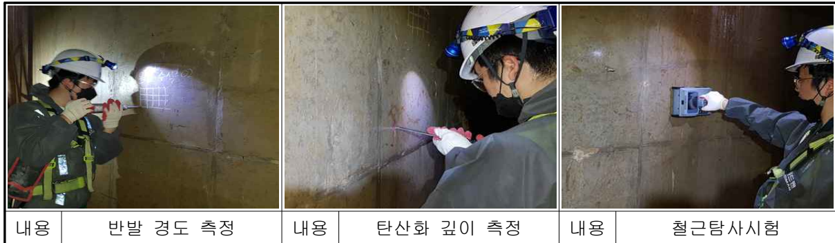
【사진 1.21】 원흥수색 재료시험 전경
